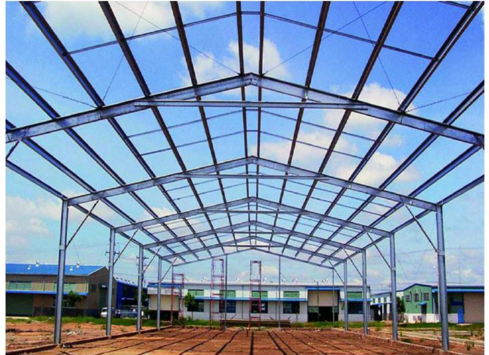
لاپه های سقف یک سوله
