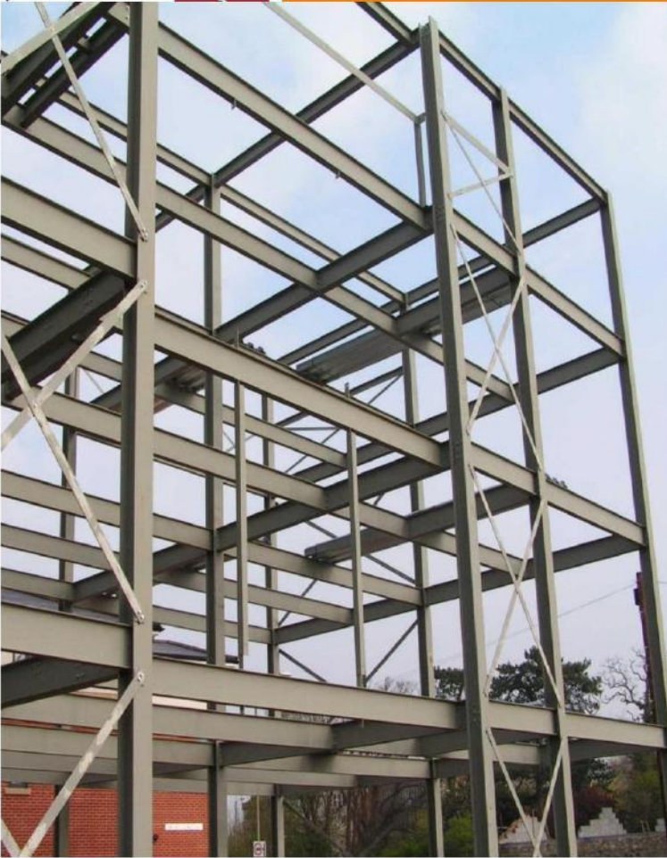
تیرهای فولادی در یک ساختمان
